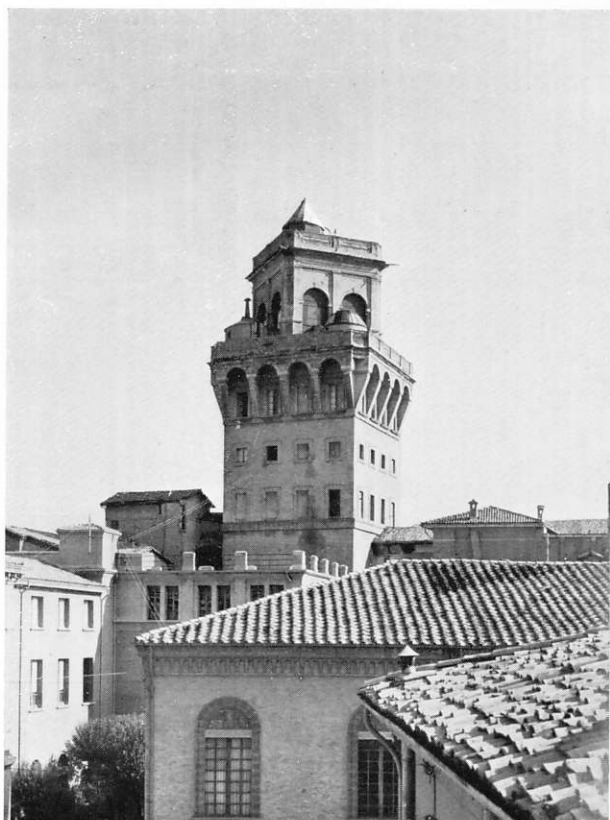
TORRE DELL'OSSERVATORIO UNIVERSITARIO DI BOLOGNA. SOVRASTA IL PALAZZO CENTRALE DELL'UNIVERSITÀ.
