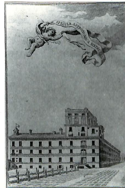
3 Facciata dell'osservatorio visto da meridione.
