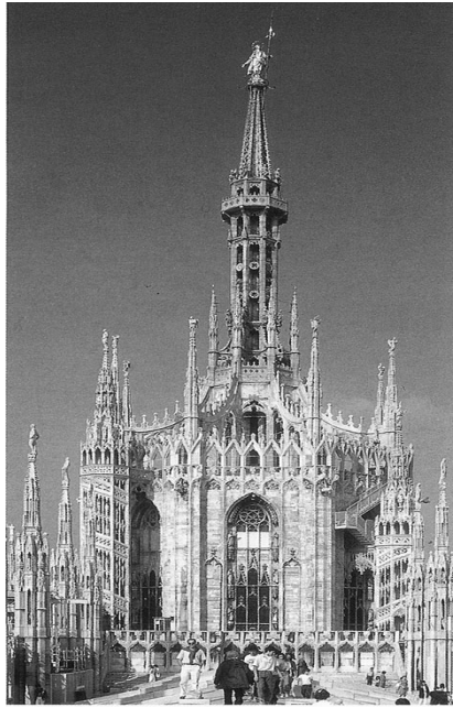
Figura 2.5 Veduta esterna del tiburio.
